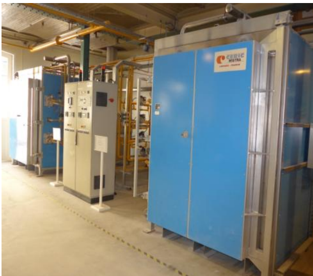
Fours à gaz et électrique
