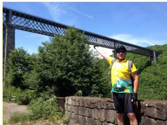
Viaduc des Fades
