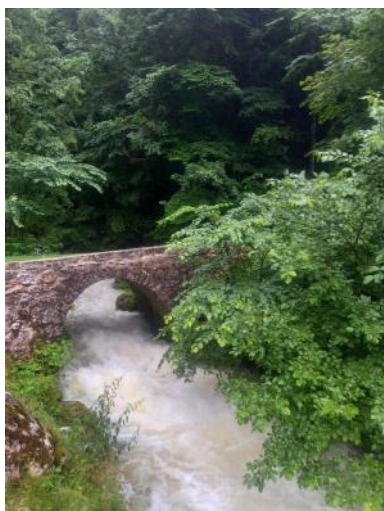
Petit pont dans la montée
