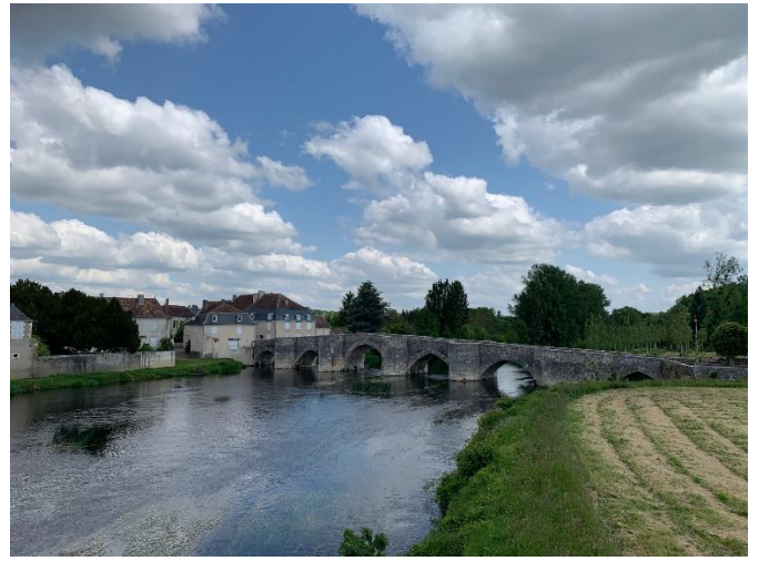
Le pont du XIIIème siècle à Saint-Savin n'est plus accessible que par les vélos et les piétons.
