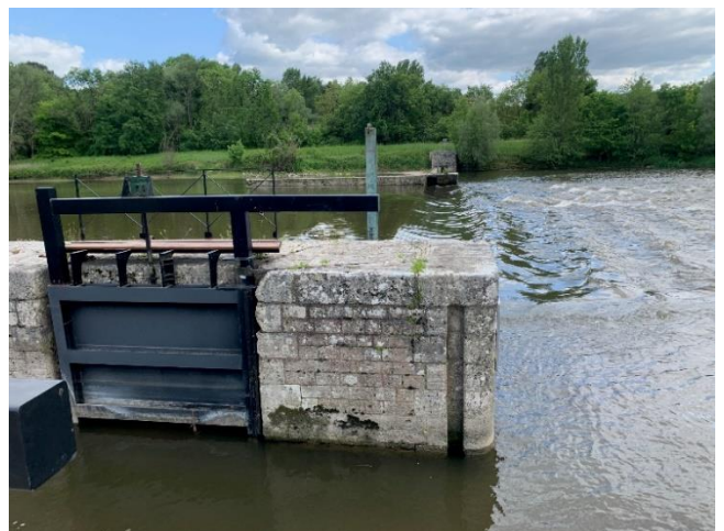
Barrage et écluse de Chisseaux
